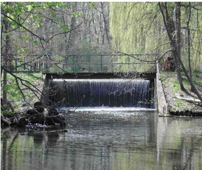
Brewster Creek YWCA dam, preconstruction
